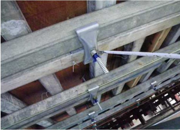
図-5 締め付けの確認
